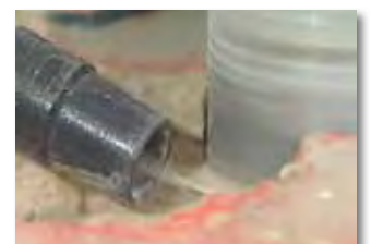
Aspiration des boues de chantier
