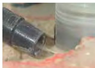
Aspiration des boues de chantier
