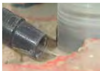
Aspiration des boues de chantier
